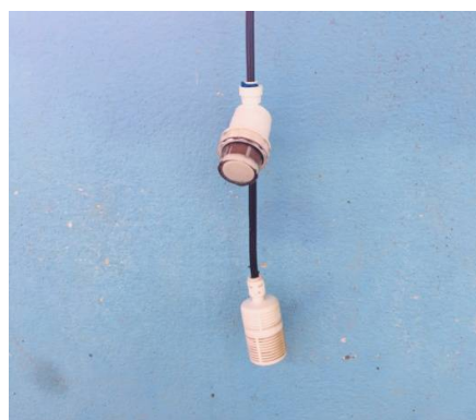
ภาพที่ 5 ชุดกรอมน้ำก่อนเข้าปั๊มแรงดันสูงสำหรับพ่นละอองน้ำ
