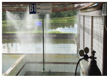
ภาพที่ 2 ลักษณะของการพ่นละอองน้ำของระบบควบคุมความชื้นสัมพัทธ์
