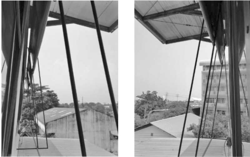
ภาพที่ 2 การติดตั้งอุปกรณ์บังแดดเพื่อป้องกันแสงแดดที่ผนังห้องทดลอง
