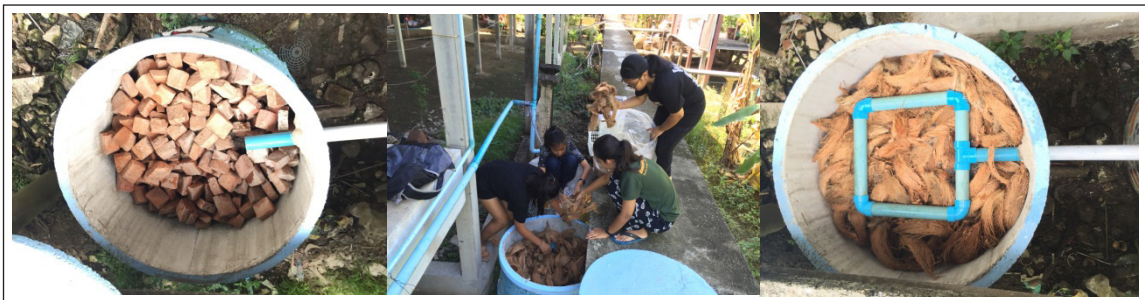
รูปที่ 7 การเพิ่มวัสดุกรองด้วยกากมะพร้าว
