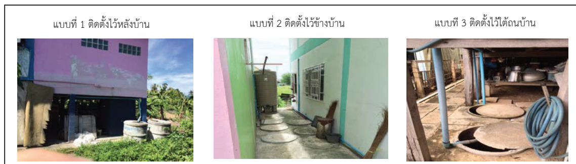
รูปที่ 3 การจัดพื้นที่ติดตั้งถังในบริเวณบ้าน
