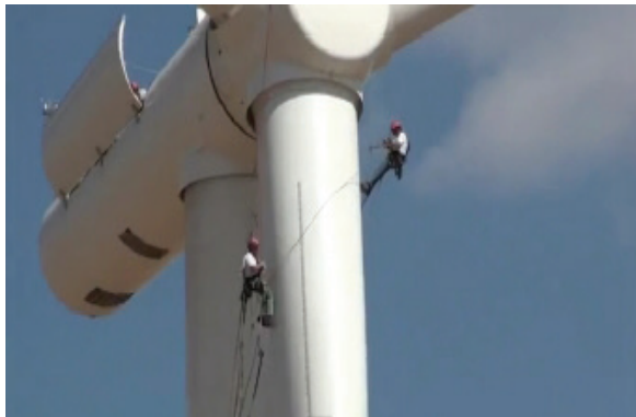
ภาพที่ 1 พนักงานตรวจสอบใบกังหันโดยการไต่ลงจากห้องเครื่องกังหันลม ที่มา: Jeon et al. (2012)
