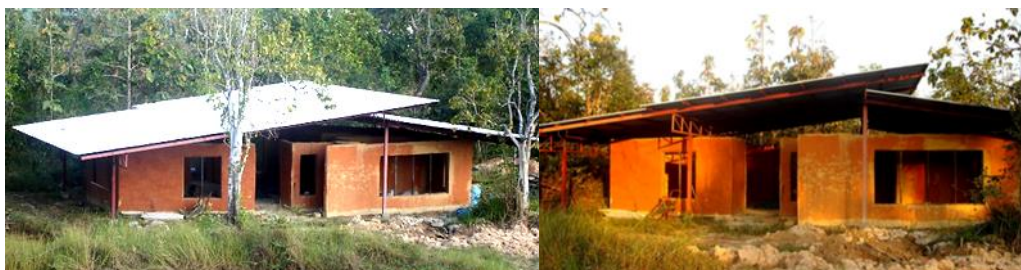
รูปที่ 5 อาคารต้นแบบเพื่อกิจกรรมนักศึกษา ก่อสร้างด้วยกระบวนการบ้านดิน
