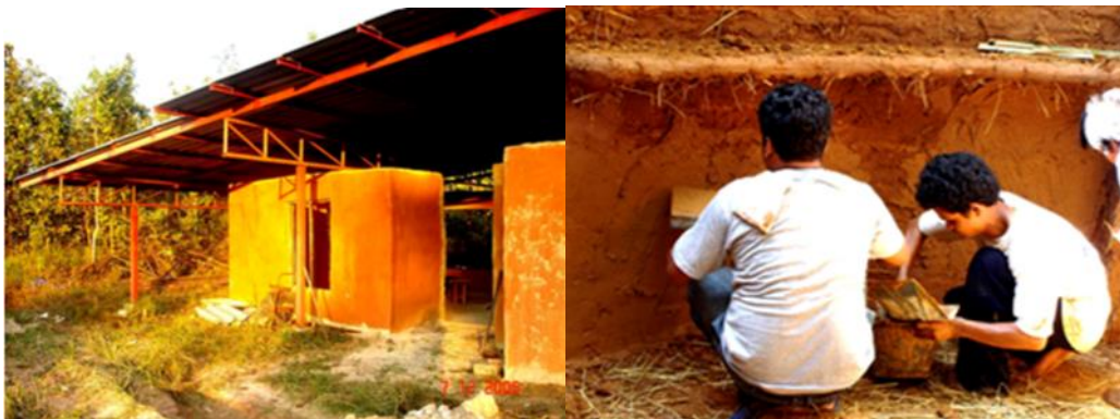
รูปที่ 2 อาคารต้นแบบ และกระบวนการก่อสร้างบ้านดินโดยการมีส่วนร่วม
