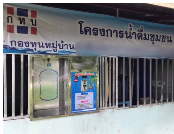
รูปที่ 2 ตู้น้ำดื่มหยอดเหรียญอัตโนมัติประเภทมีหัวบรรจุติดตั้งอยู่ที่ผนังภายนอกอาคาร รูปแบบที่มีช่องสำหรับจ่ายน้ำ อาจมีหรือไม่มีประตูเปิด-ปิด
