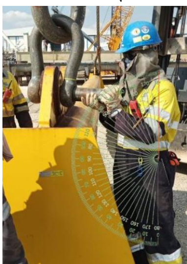
ภาพที่ 14 ทำทางขณะยกน็อตตัวผู้ใส่รูตัวสเก้น หลังปรับปรุง
