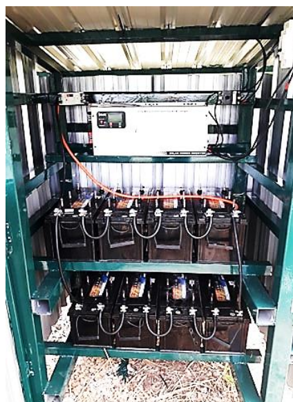
(ค) แบตเตอรี่แบบ Deep cycle และ Inverter ขนาด 6 kW
