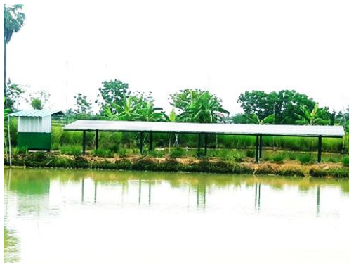
(ก) เครื่องกำเนิดไฟฟ้าพลังงานแสงอาทิตย์แบบออฟกริด
