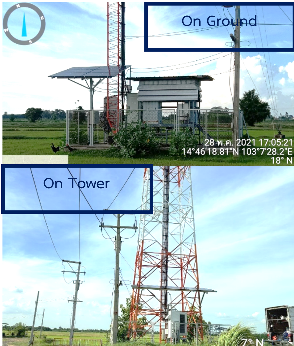
รูปที่ 6 รูปแบบติดตั้งโซล่าเซลล์ที่สถานีเสาสัญญาณโทรศัพท์
