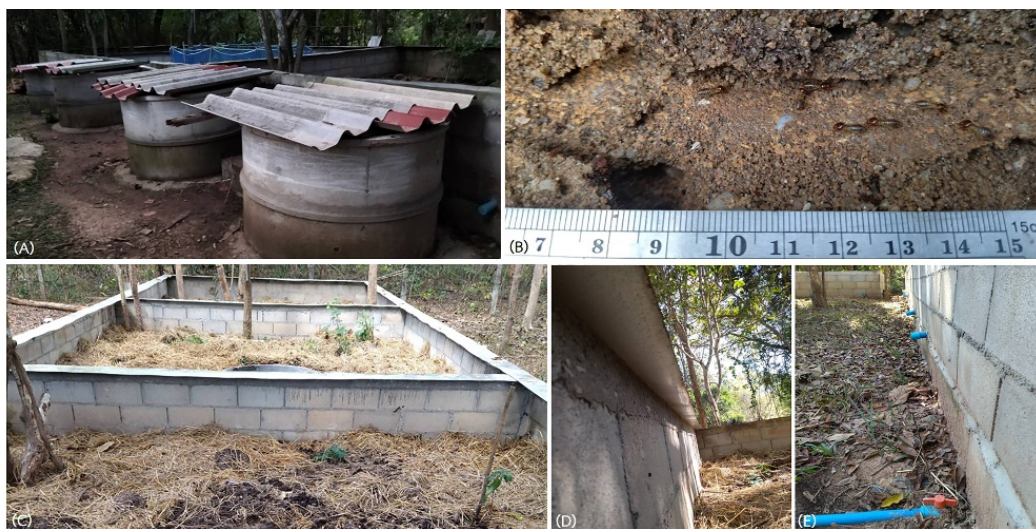
รูปที่ 3 (A) ลักษณะบ่อคอนกรีตแบบกลม, (B) อาหารที่ให้ประจำวันคือปลวก, (C) สภาพบ่อคอนกรีตแบบสี่เหลี่ยมด้านบนเปิดโล่ง, (D) ขอบบ่อมีคานรอบและปิดทับด้วยแผ่นสังกะสีให้มีส่วนยื่นเข้าไปในบ่อกันอึ่งปากขวดปีนหนี, (E) ด้านข้างของบ่อเจาะเป็นช่องปิดเปิดสำหรับระบายน้ำ
