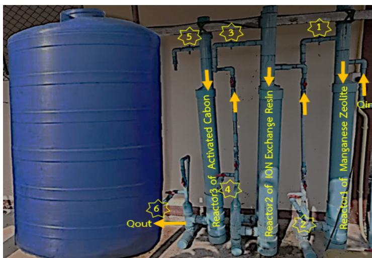
รูปที่ 1 ระบบชุดเครื่องกรองน้ำบาดาลตัวถังพีวีซี (FSRG)
