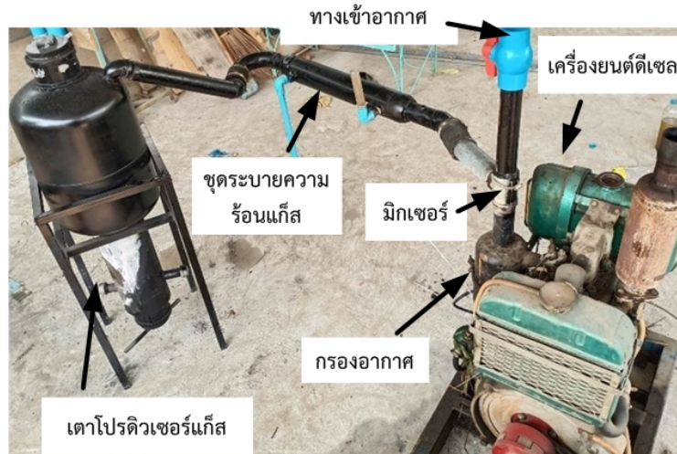
รูปที่ 4 อุปกรณ์ที่ถูกติดตั้งเพื่อการทดลอง
