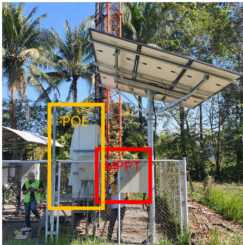
รูปที่ 4 โครงสร้างของสถานีเสาสัญญาณโทรศัพท์
