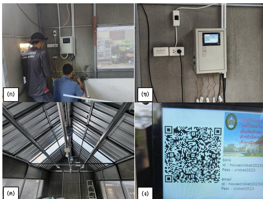
รูปที่ 6 การติดตั้งระบบควบคุมพัดลมระบายอากาศ เครื่องเป่าลมร้อน และเครื่องสเปรย์หมอกภายในโรงเรือนเลี้ยงจิ้งหรีด
