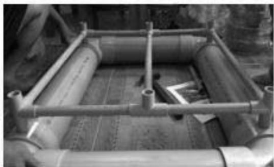
ภาพที่ 3 โครงสร้างส่วนฐานที่สมบูรณ์
