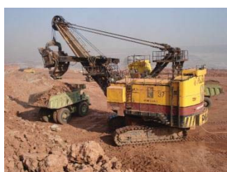
รูป 2 รถขุดไฟฟ้า
