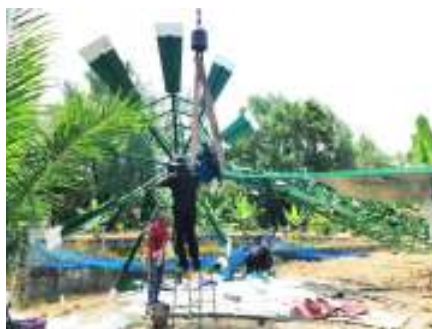
ภาพที่ 7 ประกอบกังหันลมแบบหลายใบสำหรับระบบอัดอากาศ
