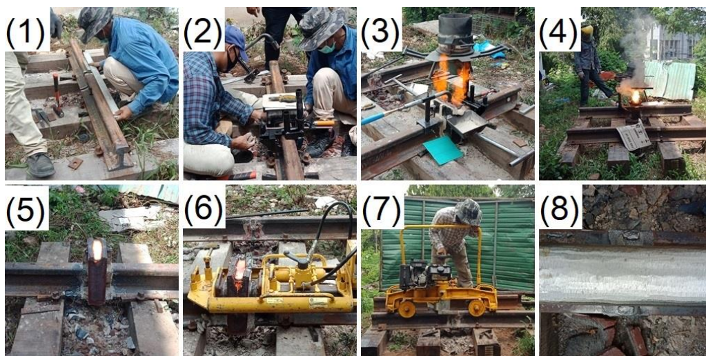
ภาพที่ 3 แสดงขั้นตอนการเชื่อมรางโดยวิธีเทอร์มิต (Thermite welding)
