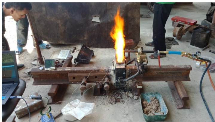
ภาพที่ 9 แสดงการติดตั้งอุปกรณ์สำหรับการวัดอุณหภูมิและการให้ความร้อน
