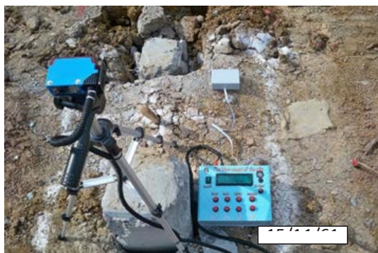
ภาพที่ 4 เครื่องนับ โบล์ว เคาท์ ฯ เสร็จสมบูรณ์
