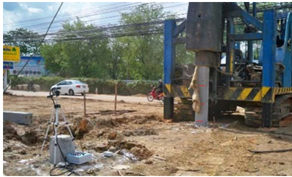
ภาพที่ 6 แสดงการทดลองการใช้เครื่องนับ โบลว์ เคาท์ ๆ กับการตอกเสาเข็มจริง
