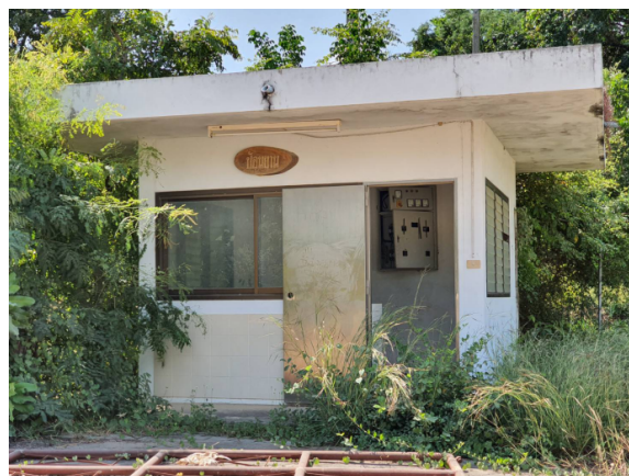
ภาพที่ 11 Building condition of Guard house
