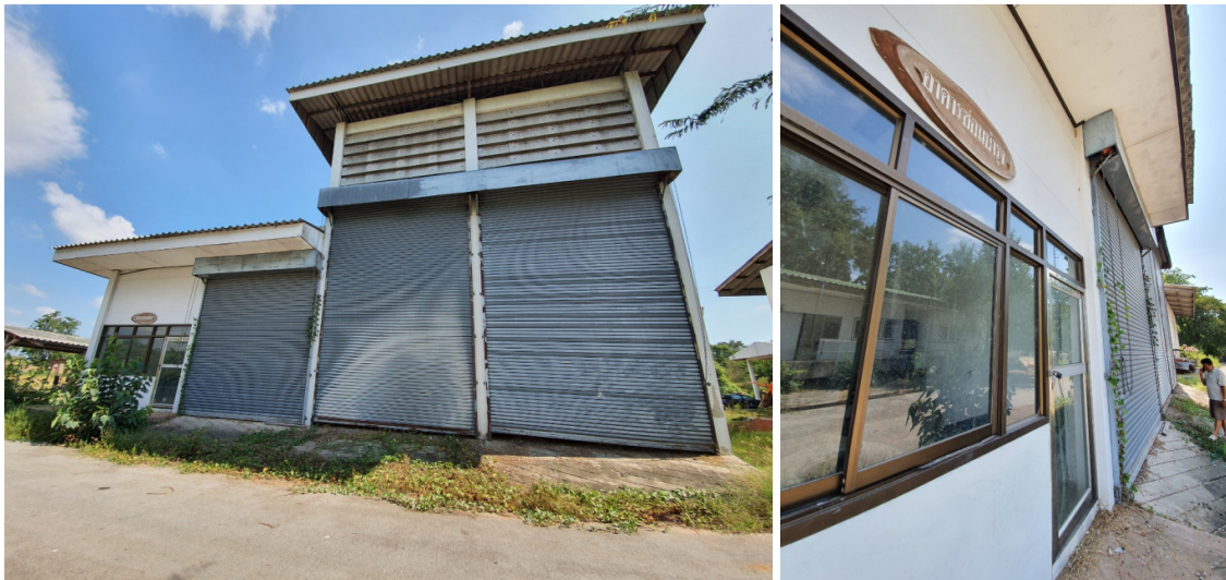
ภาพที่ 6 Building condition of maintenance building
