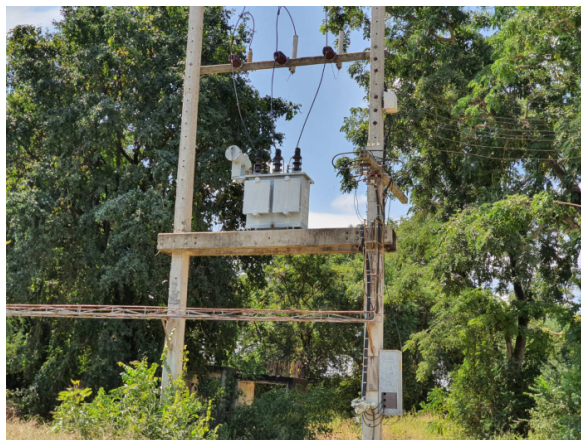
ภาพที่ 10 Building condition of transformer
