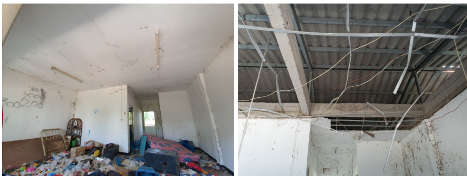
ภาพที่ 8 Building condition of staff accommodation
