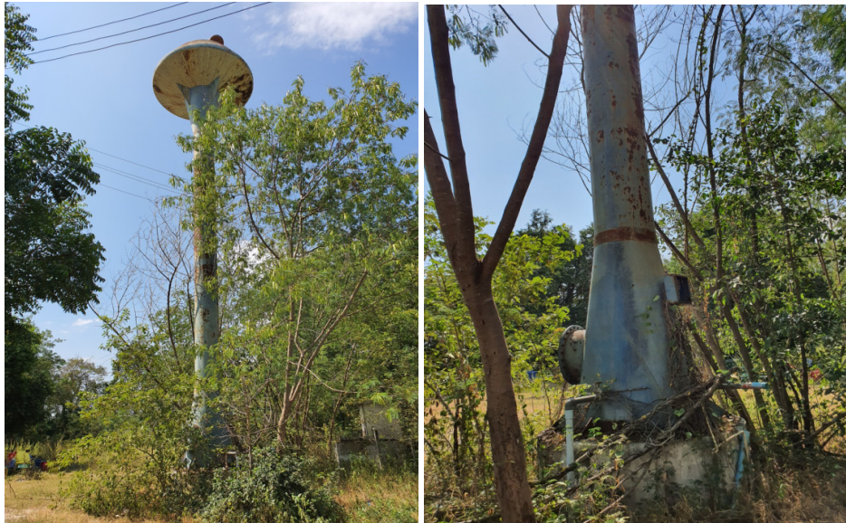
ภาพที่ 9 Building condition of water supply system
