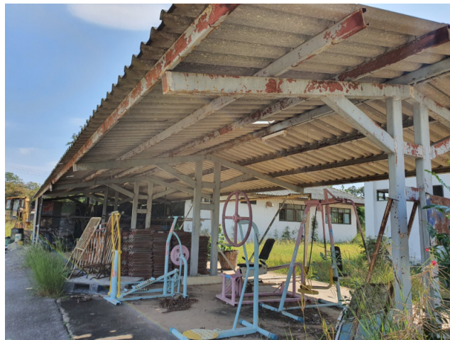
ภาพที่ 7 Building condition of car park
