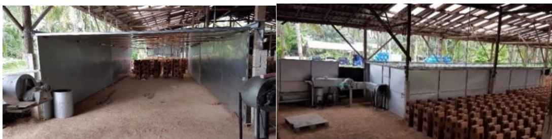
ภาพที่ 3 การสร้างและการประกอบติดตั้งต้นแบบระบบควบคุมความร้อนที่โรงงานผลิตอิฐแดง
