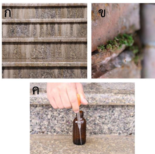
ภาพที่ 2 คราบไม่พึงประสงค์ (ก) ตัวอย่างลักษณะคล้ายหินปูน (ข) ตะไคร่น้ำ (ค) น้ำตัวฝนอย่าง
