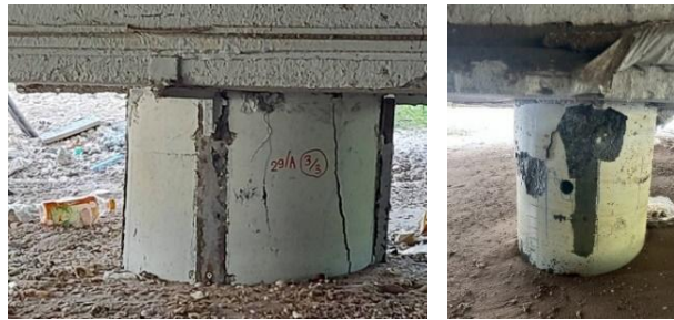
ภาพที่ 13 ลักษณะการเสื่อมสภาพรุนแรงของเสาตอม่อด้วยพฤติกรรมเสาสั้นจากการทับถมของทรายชายหาด
