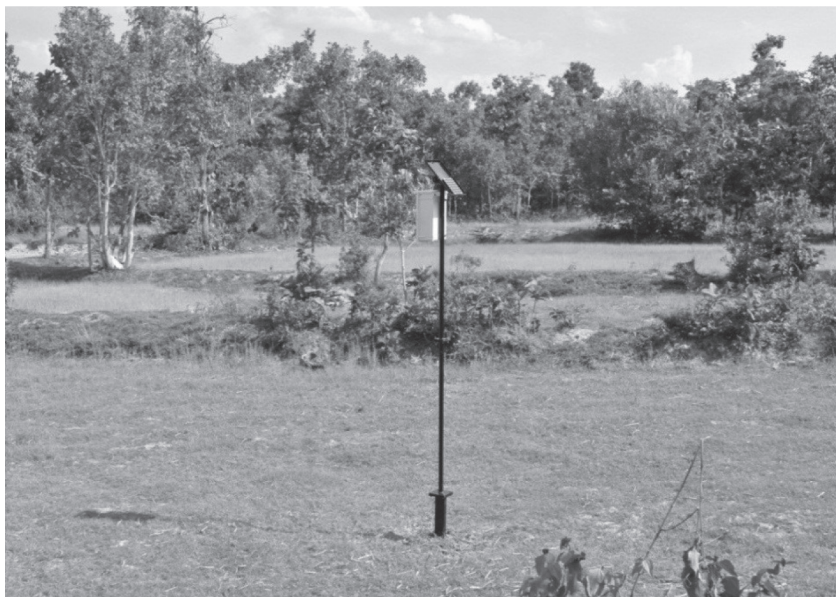
ภาพที่ 10 การติดตั้งเซ็นเซอร์โนดที่ทำหน้าที่เป็นโนดอ้างอิง
