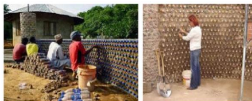
รูปที่ 1 การจัดเรียงขวดพลาสติกภายในผนังดินสำหรับบ้านดิน
