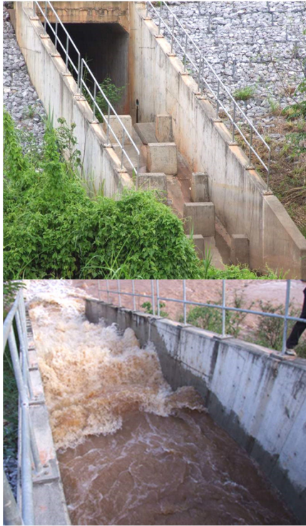
รูปที่ 1 ทางปล่อยน้ำของโรงไฟฟ้าพลังน้ำขนาดเล็ก น้ำหมัน
