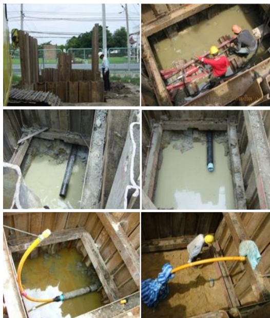
รูปที่ 4 การก่อสร้างโดยวิธีการดันทลอด
