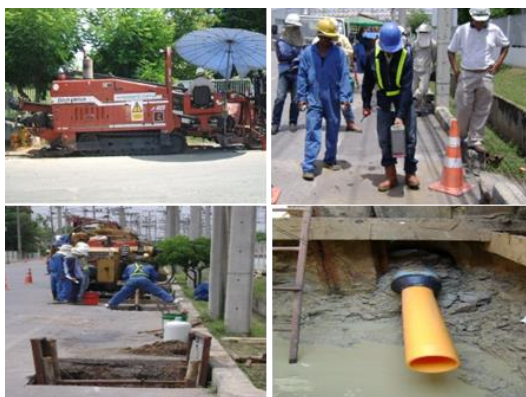
รูปที่ 3 การก่อสร้างโดยวิธีการเจาะลอด
