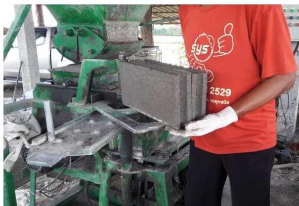
ภาพที่ 4 ขั้นตอนถอดแบบคอนกรีตบล็อก
