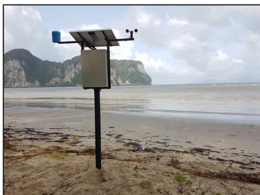
ภาพที่ 16 การติดตั้งตู้ควบคุมระบบในบริเวณชายหาด
