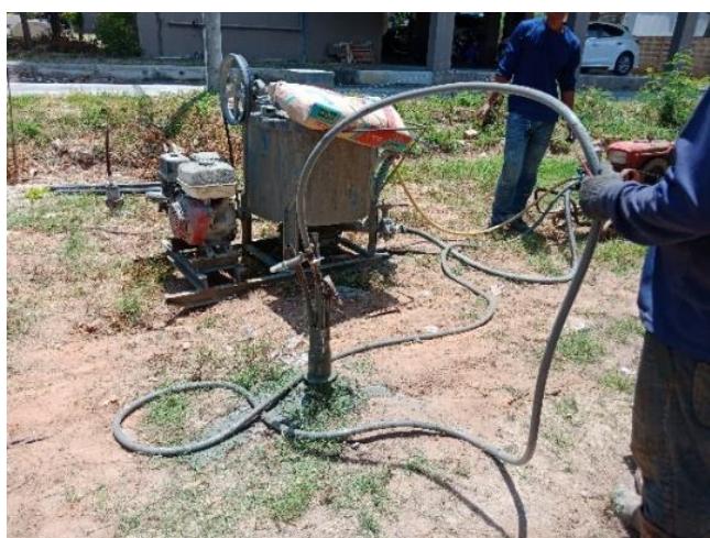
ภาพที่ 4 การอัดฉีดน้ำปูนเข้าท่อ
